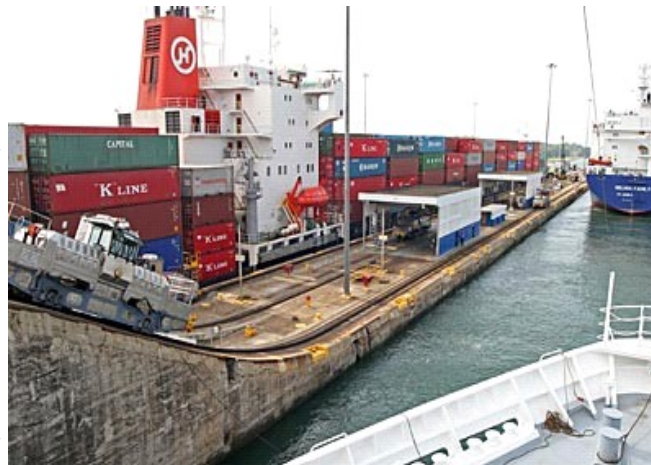
Die Lokomotiven sind so eine Art Zahnradbahn, dessen Verzahnung der großen Schiffsmasse widerstehen muss und verhindert, dass die Lokomotiven ins Schleusenbecken gezogen werden.
