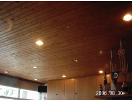
Die alte Decke ...
