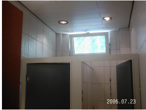
neues Damen WC
