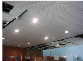
... die neue Decke
